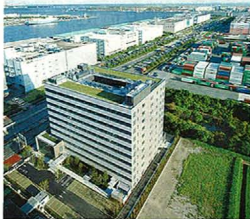
屋上緑化で環境に配慮
